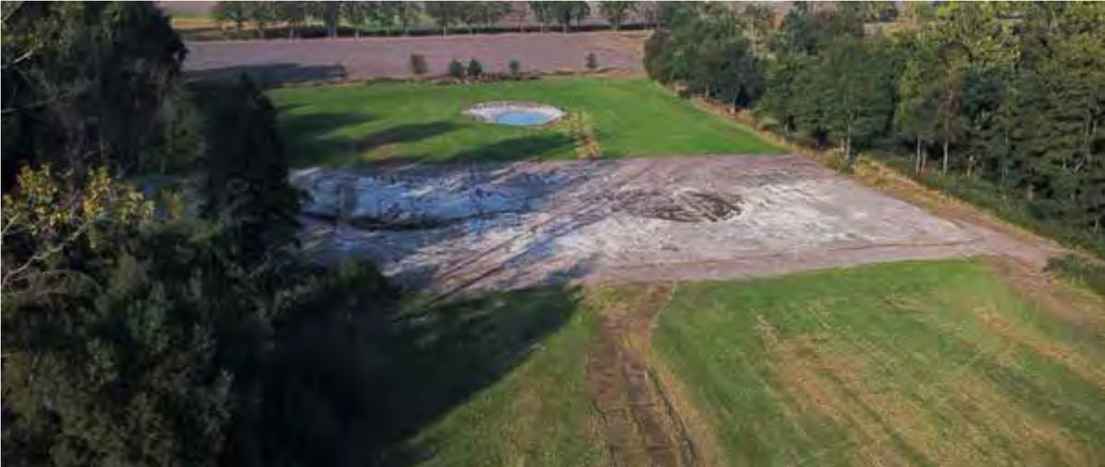
Afgraving van laagte en aanleg poel (Foto: Senne Verschraeegen)
