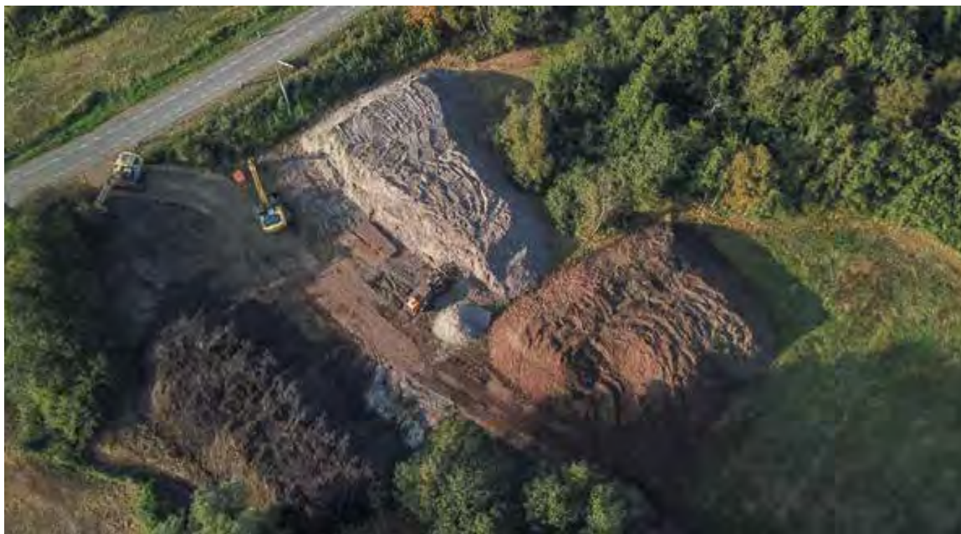
Tijdelijk gronddepot (Foto: Senne Verschraegen)
